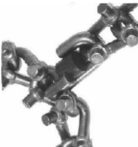
Ремонт с помощью S-образного звена цепи (вид сверху)
